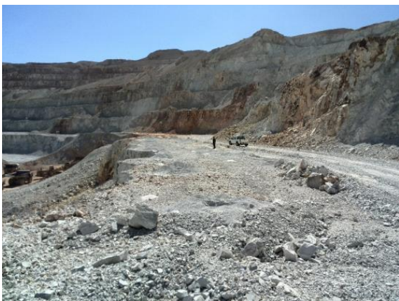
شکل ۷: موقعیت بلوک انتخابی پیش از آغاز عملیات انفجار
