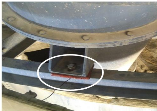
شکل ۱۰: نصب حسگر ارتعاشی پیزوالکتریک
