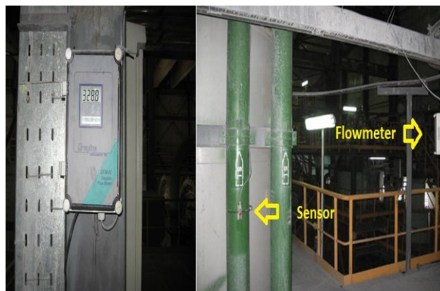
شکل ۷: فلومتر التراسونیک نصب شده در جریان باطله ستون
