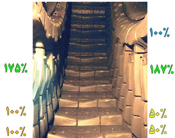
شکل ۲۵: افزایش قابل ملاحظه عمر آسترهای دیواره طرح جدید (اعداد، میزان افزایش عمر در هر یک از قطعات آستر دیواره را نشان می‌دهند)
