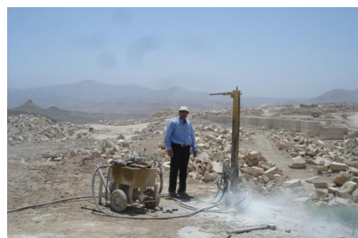
شکل ۱: انباشتگی باطله‌ها و لاشه‌های حاصل از استخراج تراورتن در مجتمع معدنی حاجی‌آباد محلات
